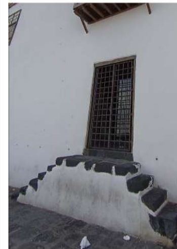
ESCALERA DE PIEDRA Y ENREJADO
