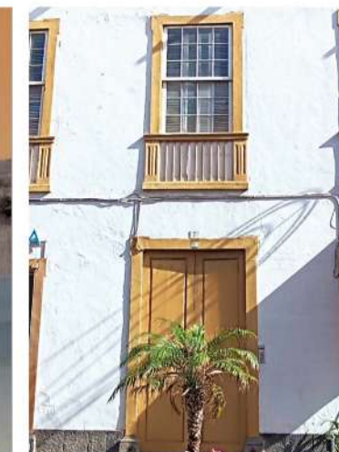
VENTANA Y PUERTA DE MADERA
