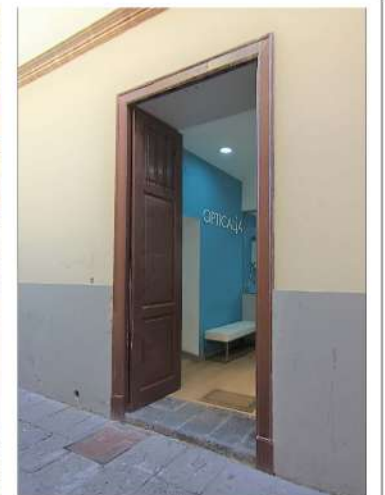
PUERTA Y PELDAÑO DE ACCESO
