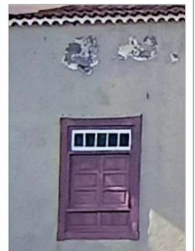
VENTANA DE MADERA Y ALERO TEJA
