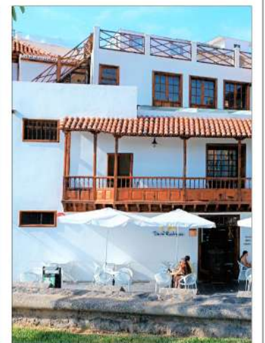
ESCALERA, BARANDILLAS, VENTANAS Y PUERTAS
