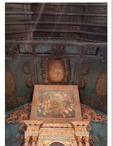
ESTRUCTURA VISTA DE CUBIERTA
