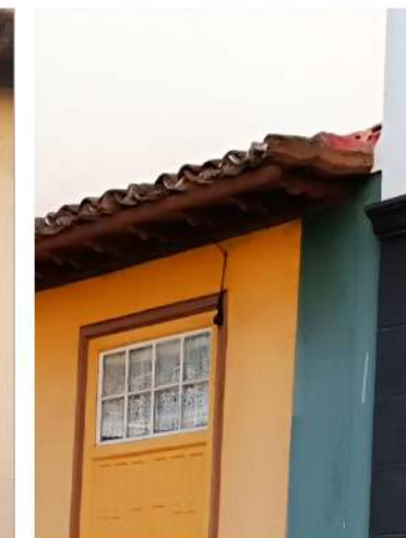
GÁRGOLA Y ALERO DE MADERA
