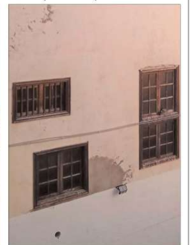
VENTANA Y VENTANILLO CON REJERÍA
