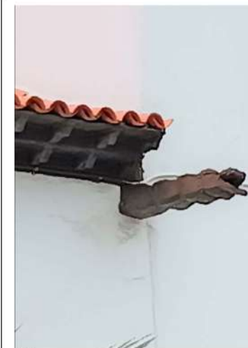
GÁRGOLA Y ALERO DE MADERA
