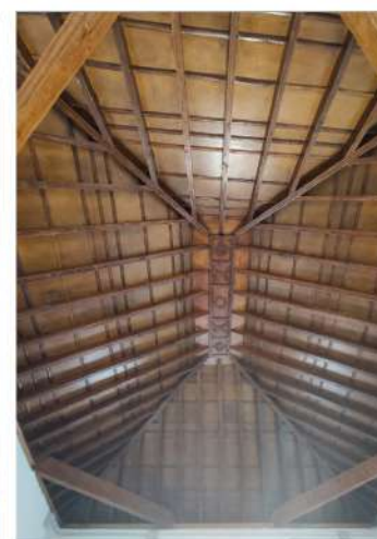
CUBIERTA DE MADERA
