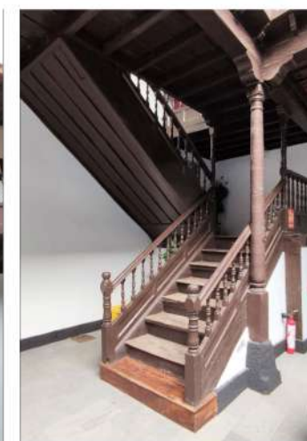
ESCALERA DE MADERA
