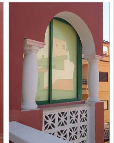
VENTANA Y COLUMNAS
