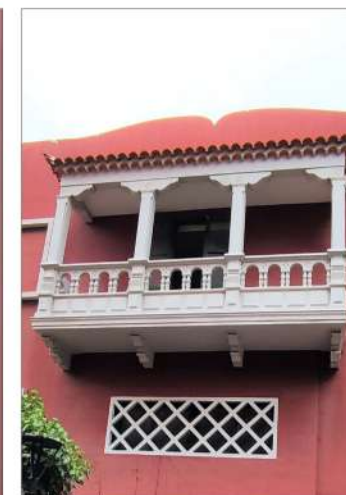
BALCÓN Y PARAPETO SUPERIOR
