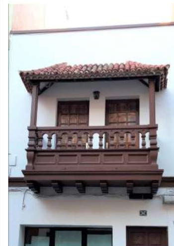
BALCÓN Y FISIONOMÍA DE PUERTA VENTANAS
