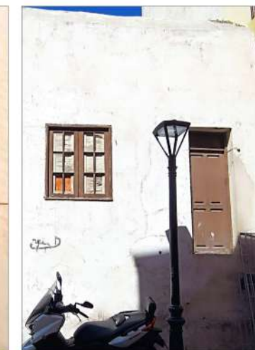
VENTANA Y PUERTA DE MADERA
