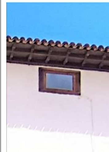
ALERO Y VENTANILLO DE MADERA
