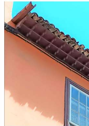
GÁRGOLA Y ALERO DE MADERA
