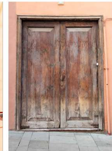
PUERTA DE ACCESO PRINCIPAL
