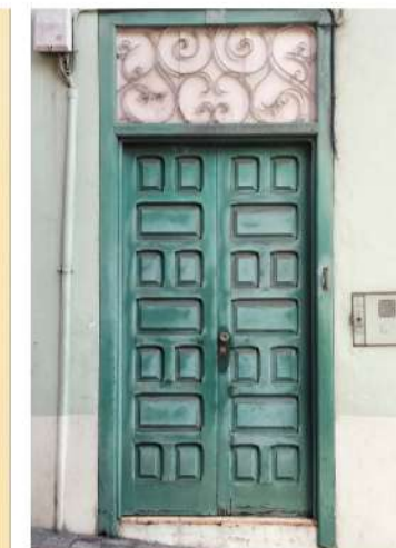
PUERTA PRINCIPAL CON REJERÍA
