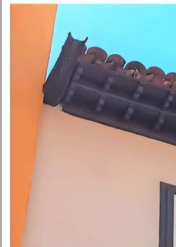
GÁRGOLA Y ALERO DE MADERA
