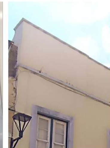
CORNISA Y MOLDURAS
