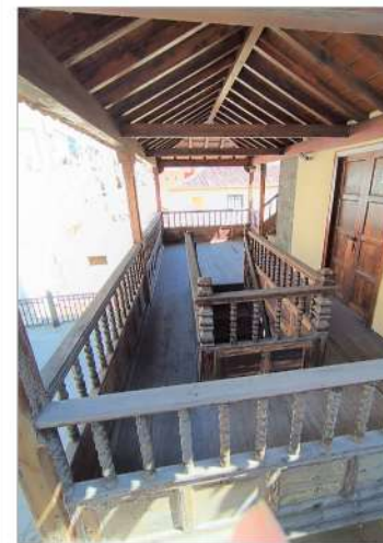
ESCALERA DE MADERA
