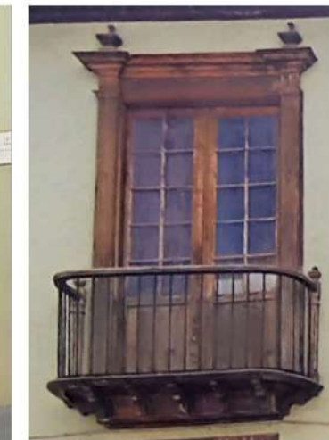
BALCÓN DE REJA Y PUERTAVENTANA
