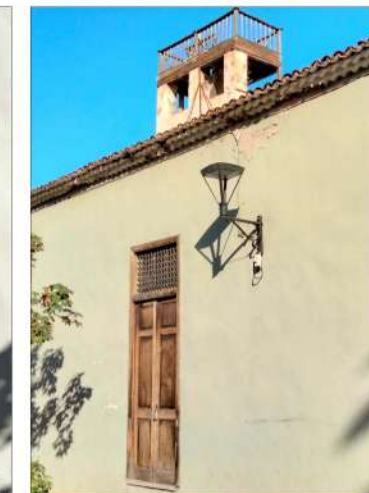
MIRADOR, ALERO Y PUERTA DE REJA
