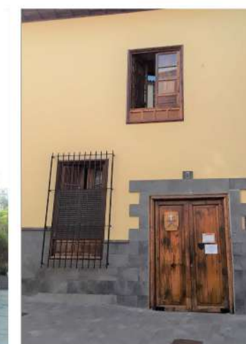
PUERTA Y VENTANAS DE MADERA
