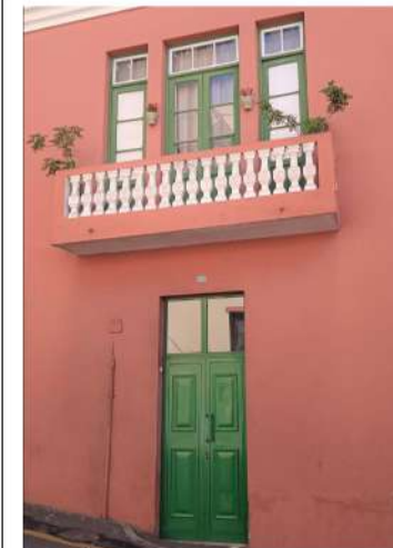
BALCÓN Y PUERTAVENTANAS
