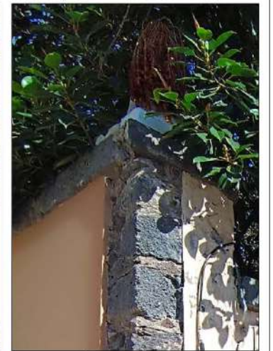
CORONACIÓN DE MURO DE PIEDRA
