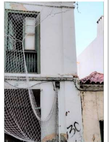
PILASTRA Y RECERCADO DE ZÓCALO
