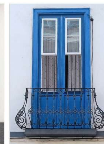
BALCÓN DE REJA Y PUERTAVENTANA
