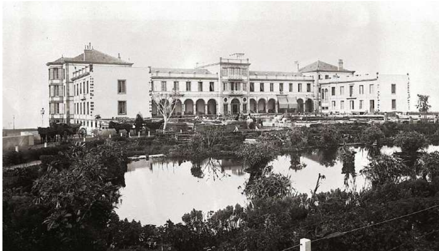
Ilustración Fachada del Hotel Taoro
