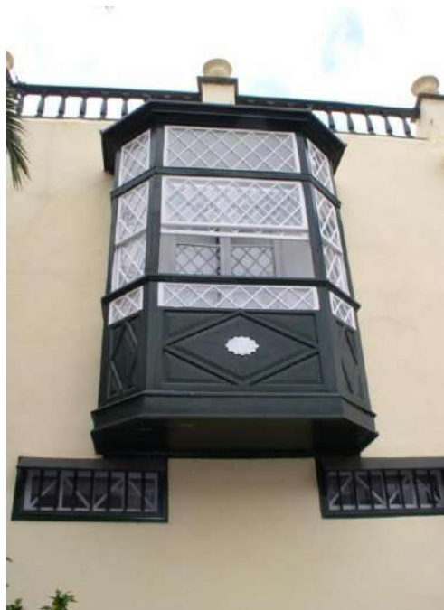
Ilustración Balcón cerrado del Sitio Litre, con cubierta de zinc.
