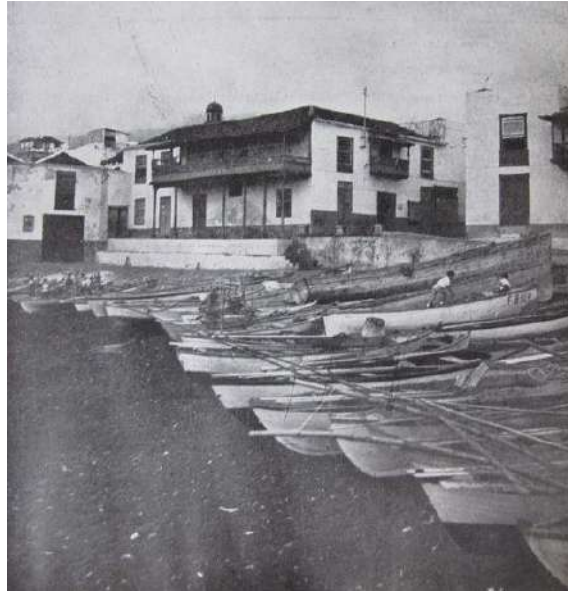
Ilustración El muelle y la antigua Casa Sindical
