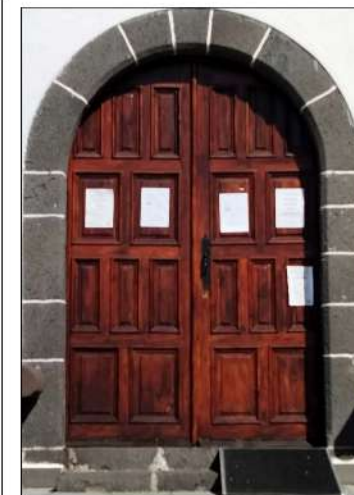
PELDAÑOS Y ARCO DE DOVELAS EN PIEDRA
