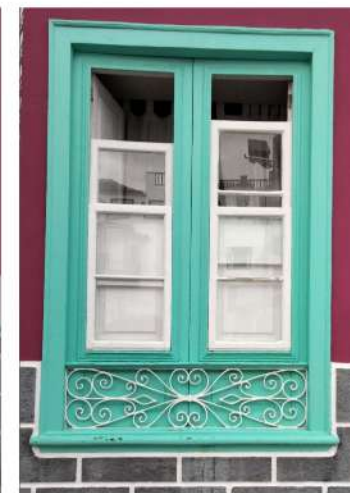
VENTANA Y ANTEPECHO DE FORJA
