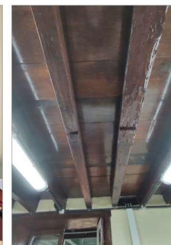
FORJADO DE MADERA
