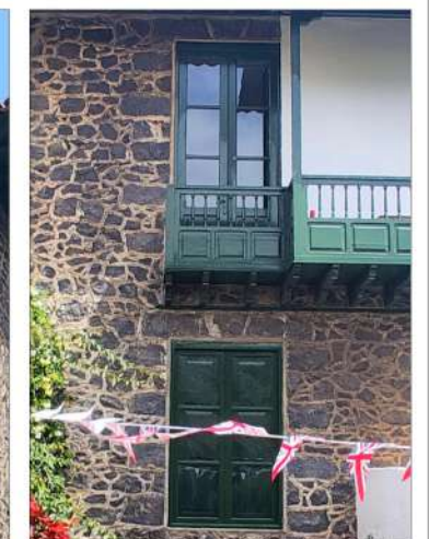
PUERTA Y VENTANA DE MADERA
