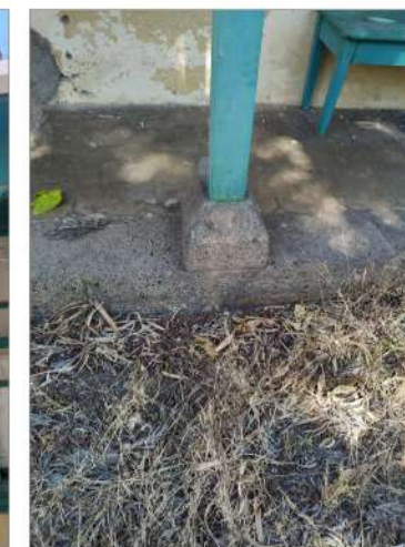
ESCALÓN EN PIEDRA Y PAVIMENTO DE CEMENTO
