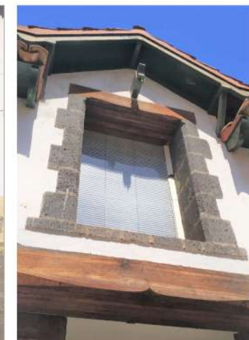
VENTANA CON CHAMBRANA DE PIEDRA Y MADERA
