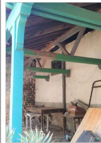
ESTRUCTURA PORCHE Y VENTANA DE MADERA
