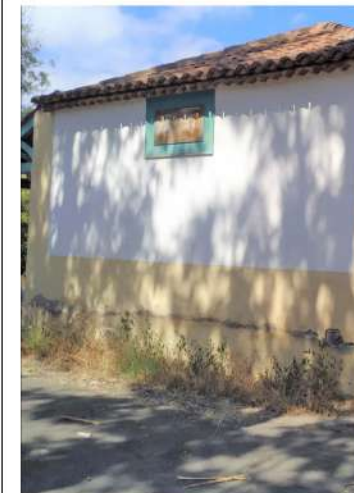
ALERO DE TEJA Y VENTANA MADERA
