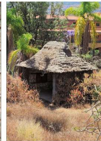
CUBIERTA DE CAÑIZO
