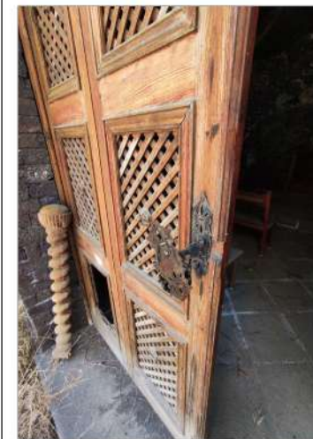
DETALLE PUERTA Y BALAUSTRADA DE MADERA
