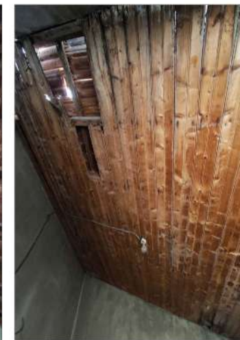
ESTRUCTURA DE CUBIERTA
