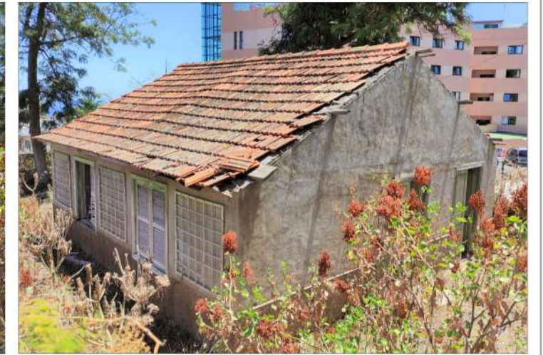
FACHADA FE03 Y FE04
