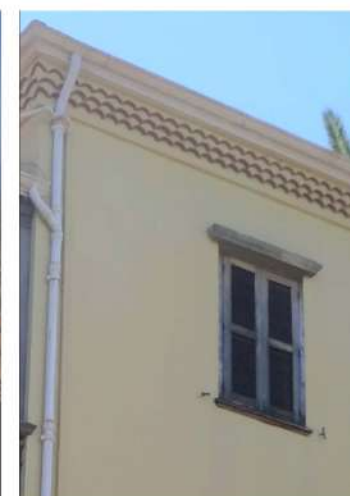
ALERO, CORNISA Y VENTANA
