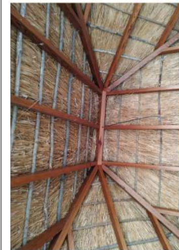
ESTRUCTURA DE CUBIERTA
