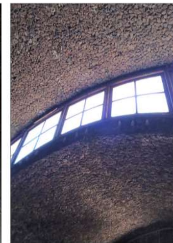
VENTANAL DE MADERA
