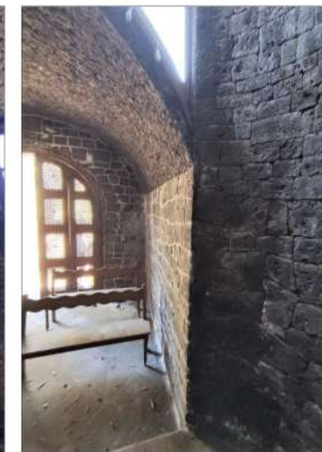
REVESTIMIENTO Y PAVIMENTO DE PIEDRA
