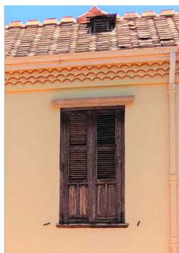
ALERO DE TEJA Y VENTANAS
