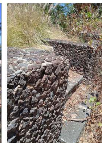
MUROS Y ESCALONES DE PIEDRA
