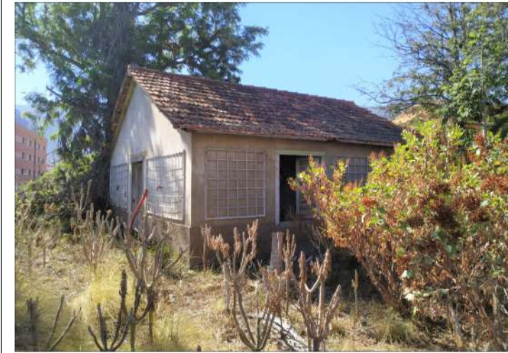
FACHADA FE02 Y FE03
