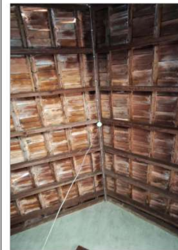
ESTRUCTURA DE CUBIERTA
