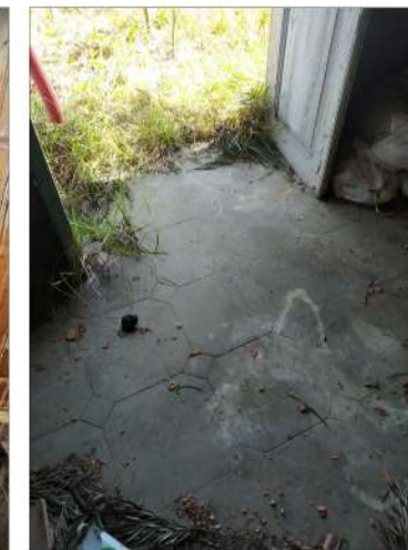
PAVIMENTO DE CEMENTO
