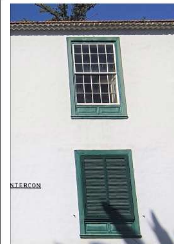
ALERO DE TEJA Y VENTANAS DE MADERA
