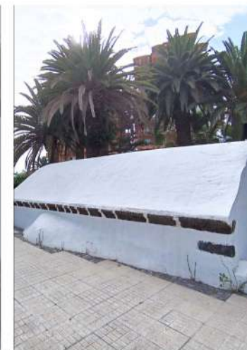
CUBIERTA DE BÓVEDA
