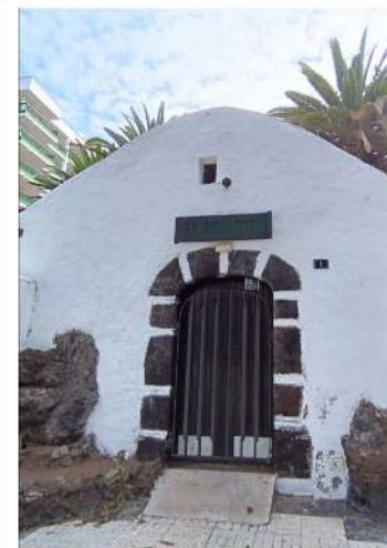
PIEDRAS VOLCÁNICAS EN FACHADA
