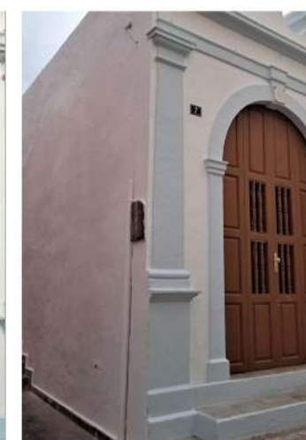
PILASTRA DE ESQUINA
