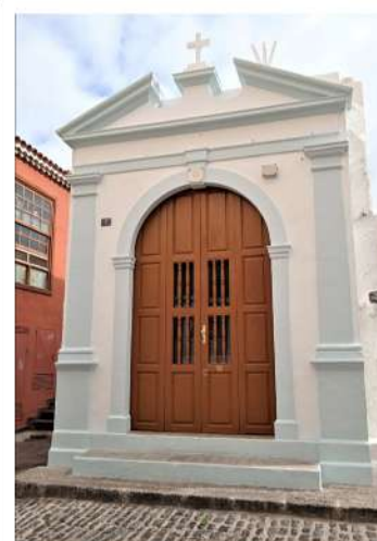
PELDAÑO DE ACCESO EN PIEDRA
